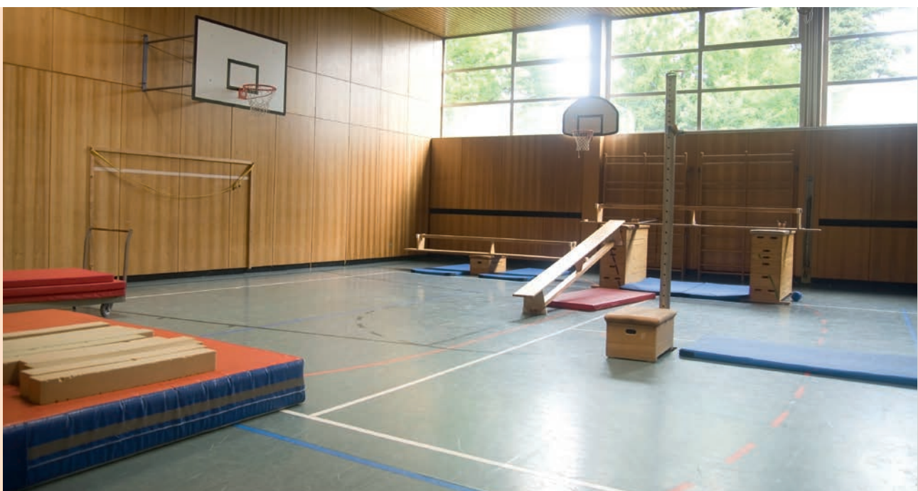
Die energetische Sanierung von Schulsporthallen lohnt sich
