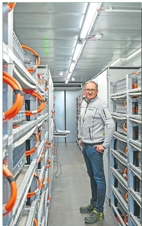
Erfahrung: Am Firmensitz von „MANN Naturenergie“ arbeiten diese 112 „second-life“-Batterien von Mercedes in einem Container. Sind sie miteinander verbunden, können so als kompakte Einheit 1,4 Megawattstunden Strom speichern – und jederzeit wieder abgeben. So ein Energiespeichersystem (ESS) in einer größeren Ausführung wäre das „Herz“ der „Energie-Drehscheibe Dreiländereck“.
