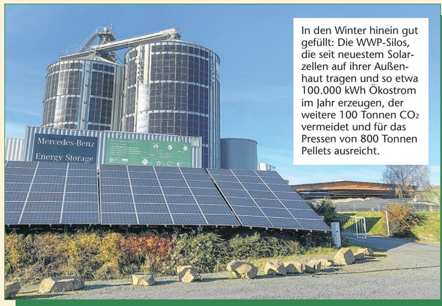
In den Winter hinein gut gefüllt: Die WWP-Silos, die seit neuestem Solarzellen auf ihrer Außenhaut tragen und so etwa 100.000 kWh Ökostrom im Jahr erzeugen, der weitere 100 Tonnen CO<sub>2</sub> vermeidet und für das Pressen von 800 Tonnen Pellets ausreicht.
