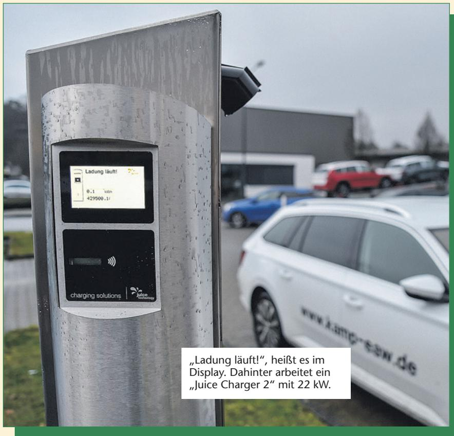
„Ladung läuft!“, heißt es im Display. Dahinter arbeitet ein „Juice Charger 2“ mit 22 kW.
