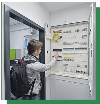
In dem unscheinbaren, kleinen, schwarzen Gehäuse im Schaltschrank bei „ContainerRent Petri“ sitzt die Technik, die verhindert, dass das Herdorfer Unternehmen teure Lastspitzen produziert, wenn an den fünf von MANN installierten Wallboxen Elektrofahrzeuge „getankt“ werden. „M-IQ“ heißt das zugrundeliegende Programm, das Kunden auf Wunsch nutzen können, die beim Langenbacher Energieversorger Ladeinfrastruktur in Auftrag geben.
