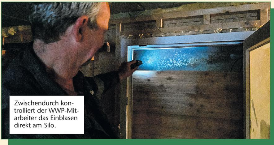
Zwischendurch kontrolliert der WWP-Mitarbeiter das Einblasen direkt am Silo.
